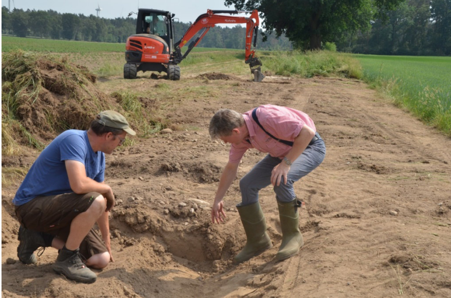
Abb. 4: Abtrag des Oberbodens an Wegrändern (F.R.A.N.Z-Projekt Rettmer)
